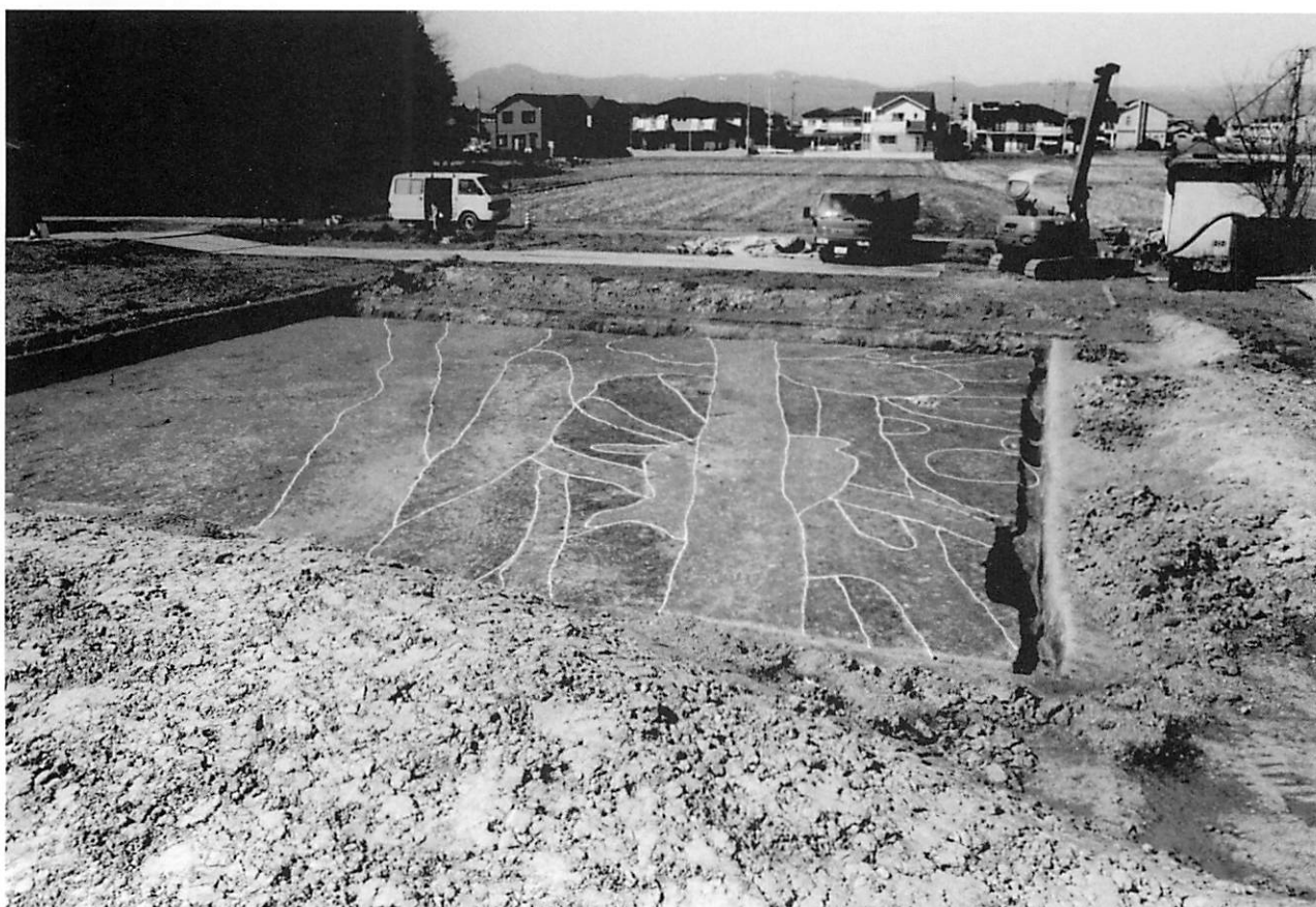
T-1 全景 (南東から)
