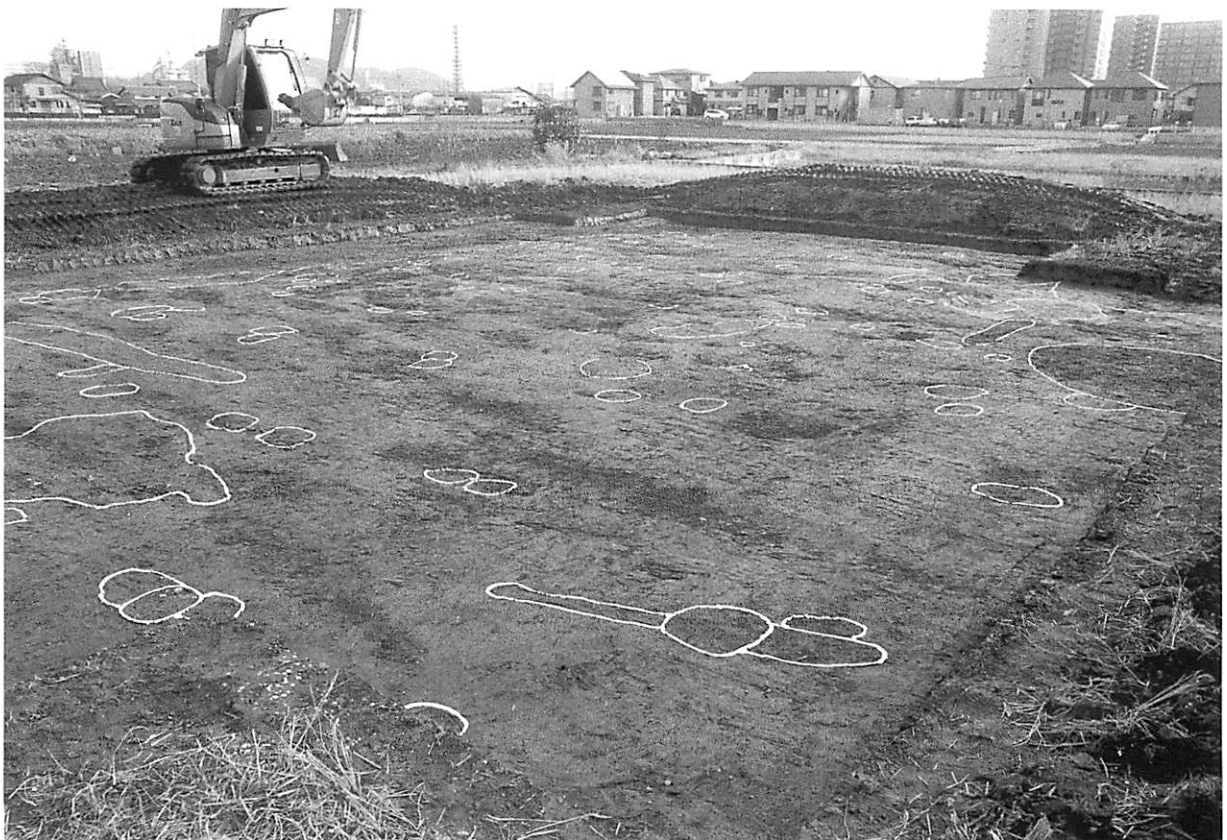
調査地全景（北から）
